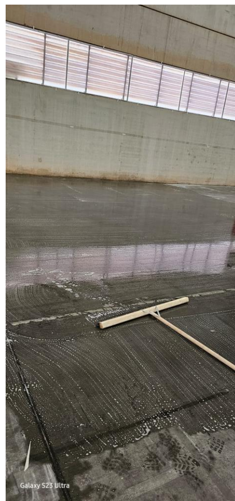
Figura 5: Limpeza de piso em obra.
