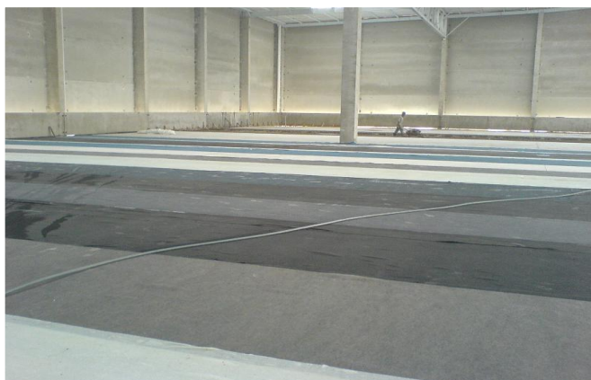
(Figura 20 – Aplicação de cura úmida)
