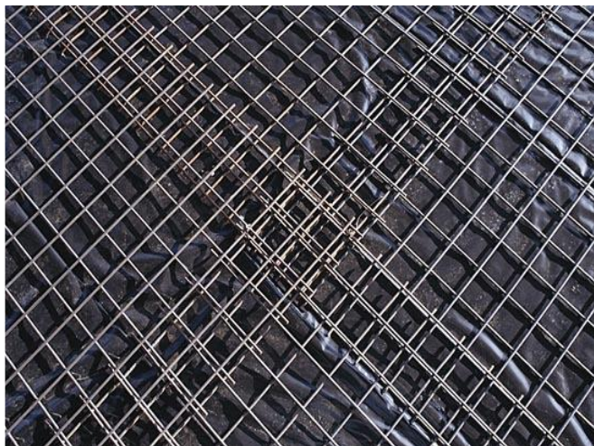
(Figura 8 – Posicionamento correto da armadura)
