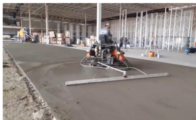
(Figura 12 – Processo de acabamento do piso)
