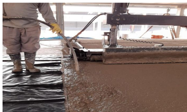
(Figura 11 – Adensamento do concreto)
