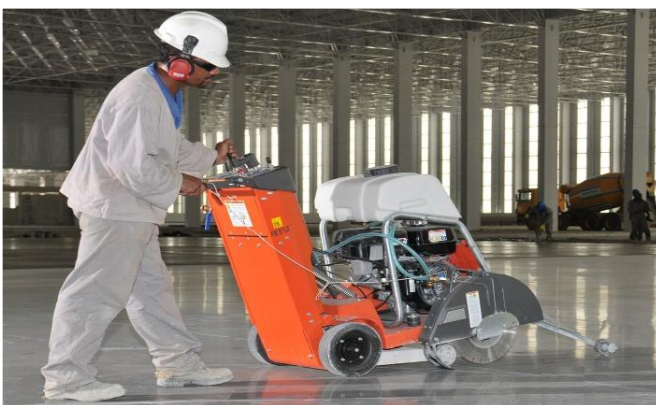
(Figura 15 – Corte das juntas)
