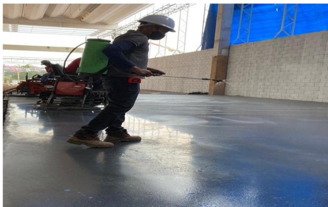
(Figura 19 – Aplicação de cura química)
