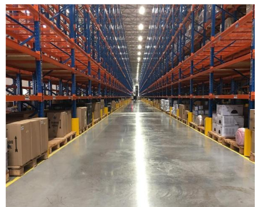
(Figura 1 – Galpão Logístico)
