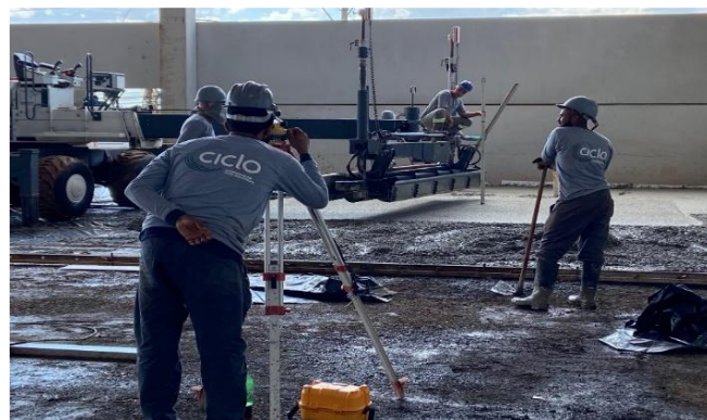
(Figura 10 – Nivelamento do concreto)
