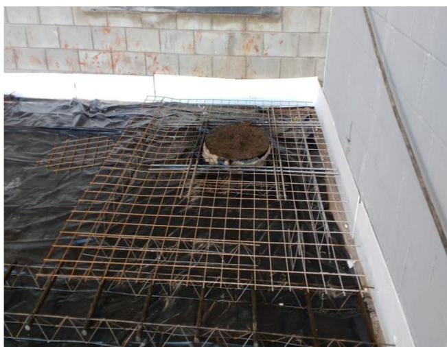
(Figura 9 – Reforço de caixa e colocação de material compressível)
