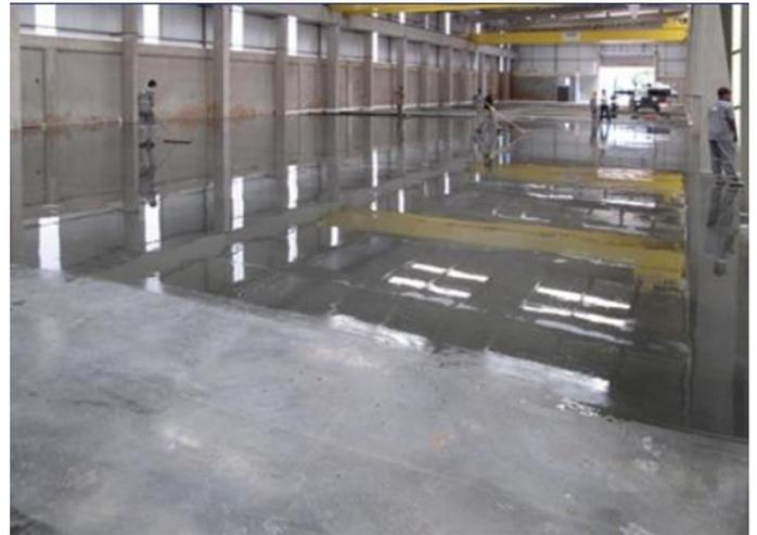
**Tempo de Reação:** Após a aplicação, o produto deve ser deixado para reagir por algumas horas. Em seguida, o excesso é removido com água e a superfície é polida para melhorar o acabamento.
