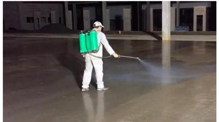
**Tempo de Cura:** Após a aplicação, o produto deve reagir por algumas horas antes da remoção do excesso. A superfície pode ser polida para realçar o brilho.
