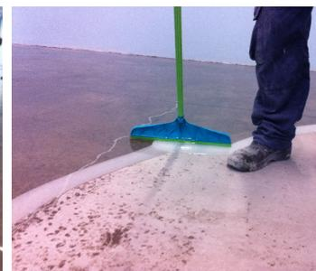
Fig. 4.2.2.1 - Adensamento polimérico
